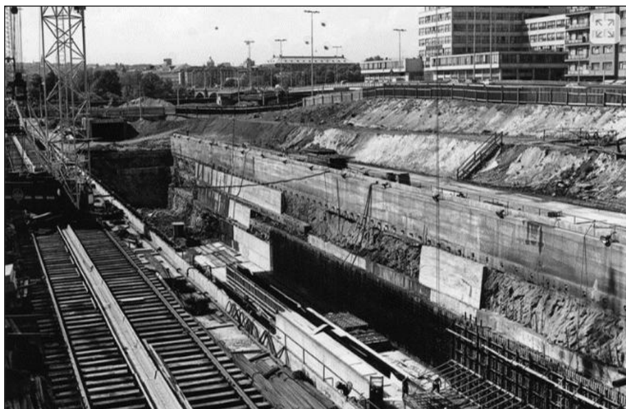
Obr. 4 Staveniště hloubené stanice metra Vltavská u severního předměstí Hlávkova mostu v roce 1981 (zdroj: archiv DPP).
